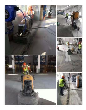
可以通过机械磨抛使石材表面焕然一新,石材翻新功能是装饰石材较重要的一个优点,天然石材不同于瓷砖等其他装饰材料,其材质均匀,具有足够的再加工厚度。从本意上讲,翻新是将陈旧的或已破损的石材表面恢复到原先新的表面状态。从广义上讲,已经把在石材安装之后进行的所有再加工技术都归结到翻新的概念之中;包括:打磨、抛光、晶硬、涂层、填缝等等,目标是追求石材装饰面的整体平整和镜面光泽;也包括:火烧、粒子喷射、化学刻蚀、研磨刷、做旧和着色等等,目标是追求石材装饰的艺术性和使用的功能性。更科学地,称为石材的"表面处理"技术。地面翻新方法我们可根据石材表面磨损程度,选择进行轻度、中度、深度的石材翻新。
